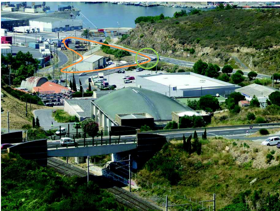
Figure 21. Enveloppe indicative du parking destiné aux poids lourds empruntant les lignes Ro-Ro (périmètre en orange ; réaménagement du carrefour en vert).
