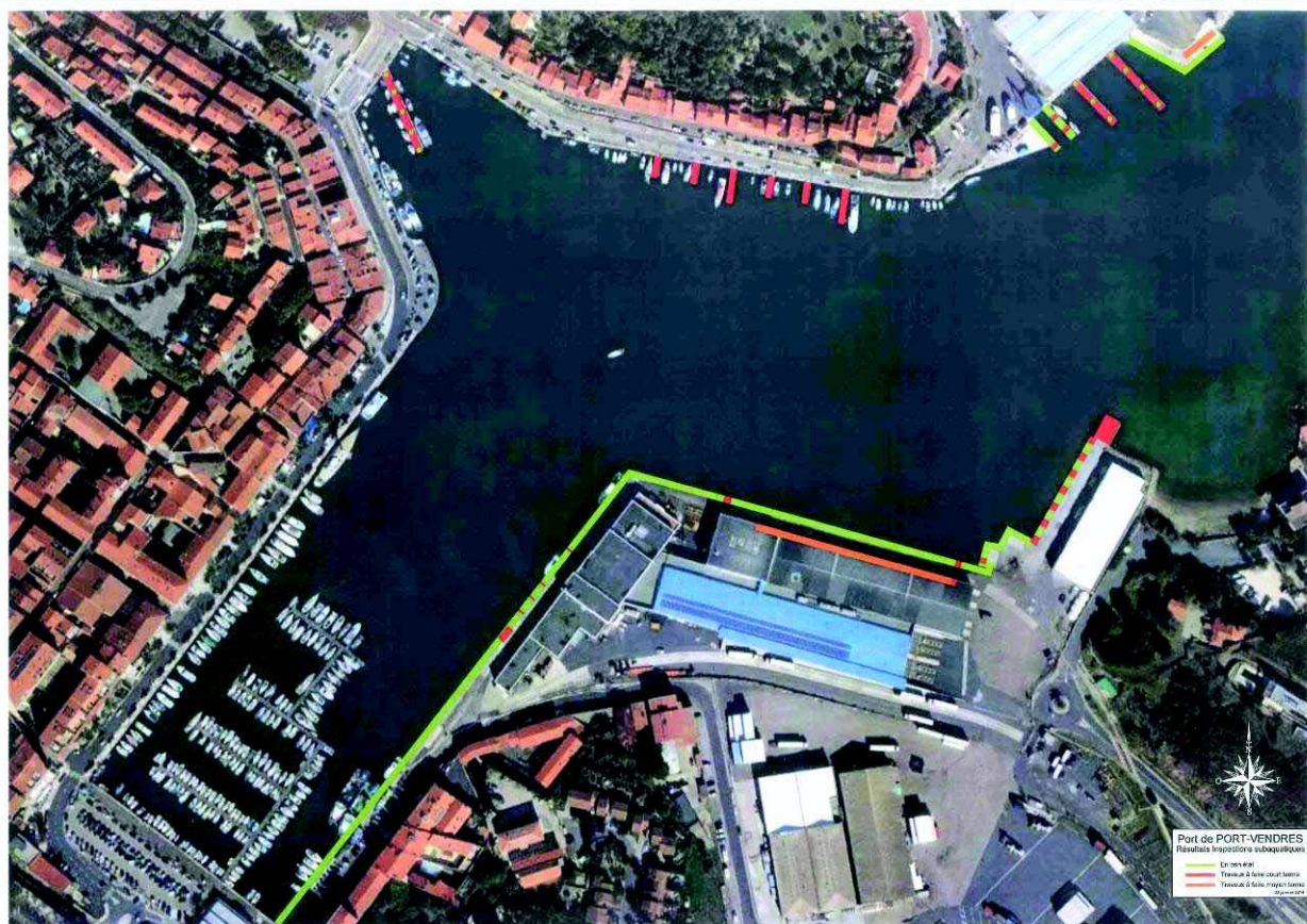
Figure 18. Hiérarchisation des différents travaux à réaliser selon l'ampleur des dégradations constatées (en vert : bon état ; en orange : travaux à faire à moyen terme et en rouge : travaux à faire à court terme).
