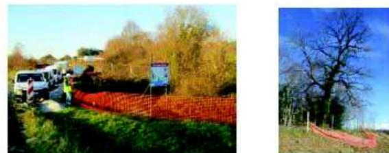
Figure 55 : Exemples de mises en défens sur un chantier (à gauche : zone humide sensible ; à droite : arbre à préserver)
