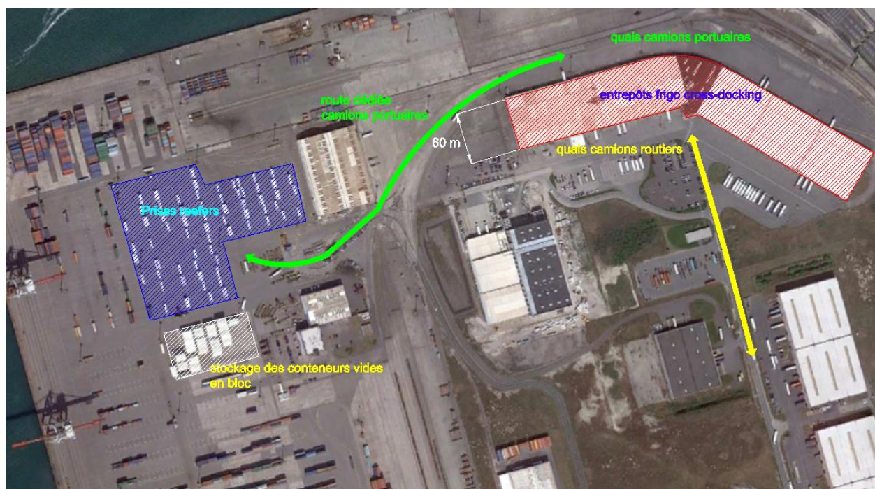
Figure 18 : illustration du Terminal à conteneurs de Dunkerque : 700 prises reefer et entrepôt frigo cross-docking dunfresh (largeur : 60m/ 70 quais camions x2, 29 000 m 2 ), ~ 30 000 EVP reefers/an : source CCO
