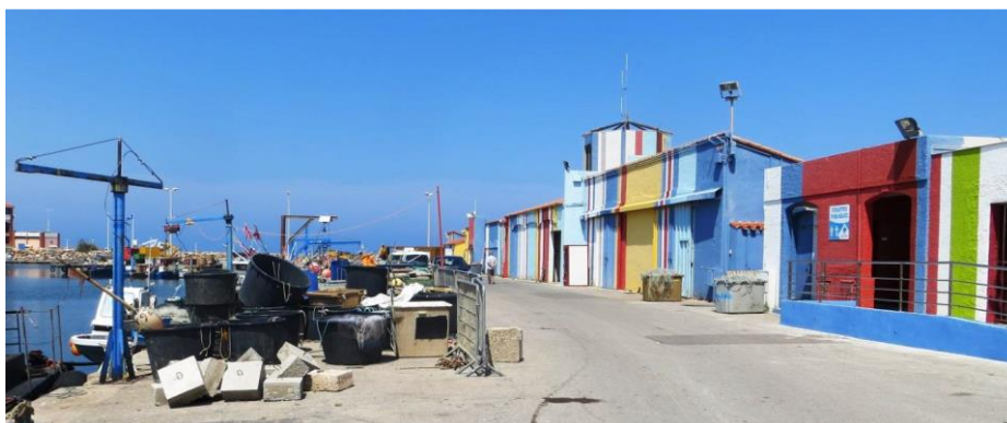
Photo 24 : Vues du prolongement du quai, jouté par des bâtiments dédiés aux professionnels de la pêche
